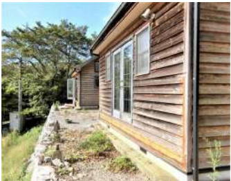
ウッドデッキ撤去後
