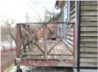
ウッドデッキ撤去前
