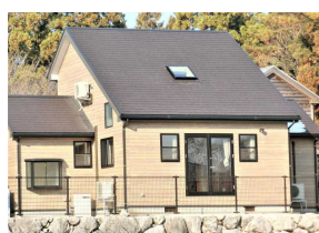
リビング側から見た様子
